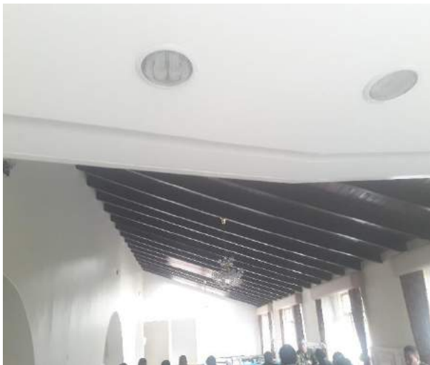
Vigas inclinadas en el comedor
