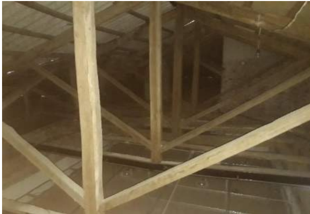
Cerchas de madera
