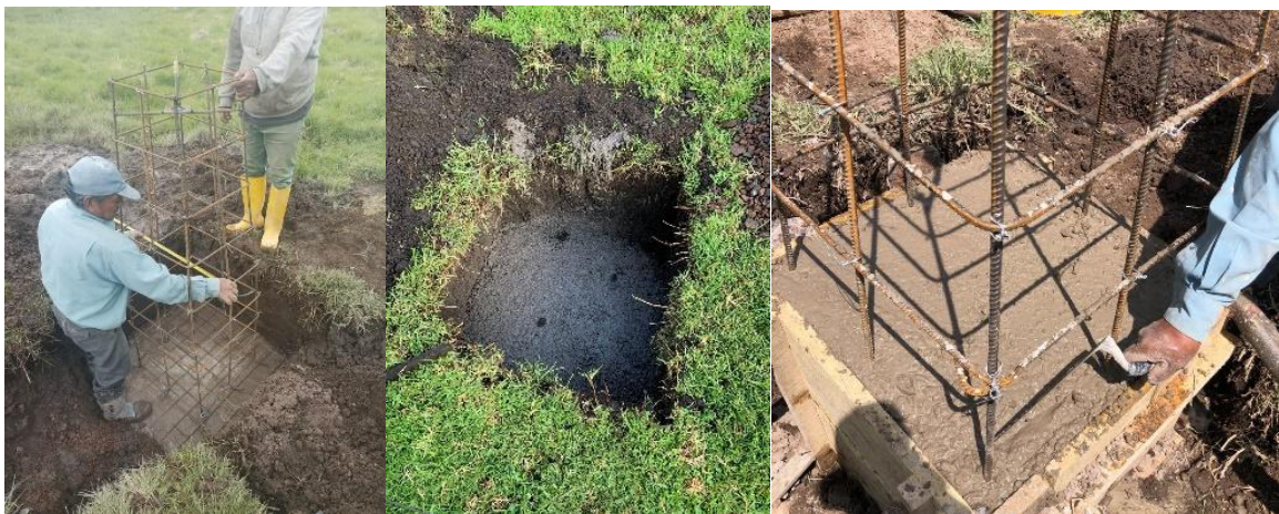
Relleno de sub-base
