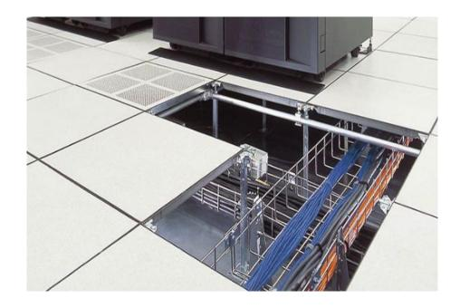
Nota. En la figura podemos visualizar la vista de una imagen real de piso falso con cableado estructurado. Fuente: Landeta y Shuguli, 2023.
