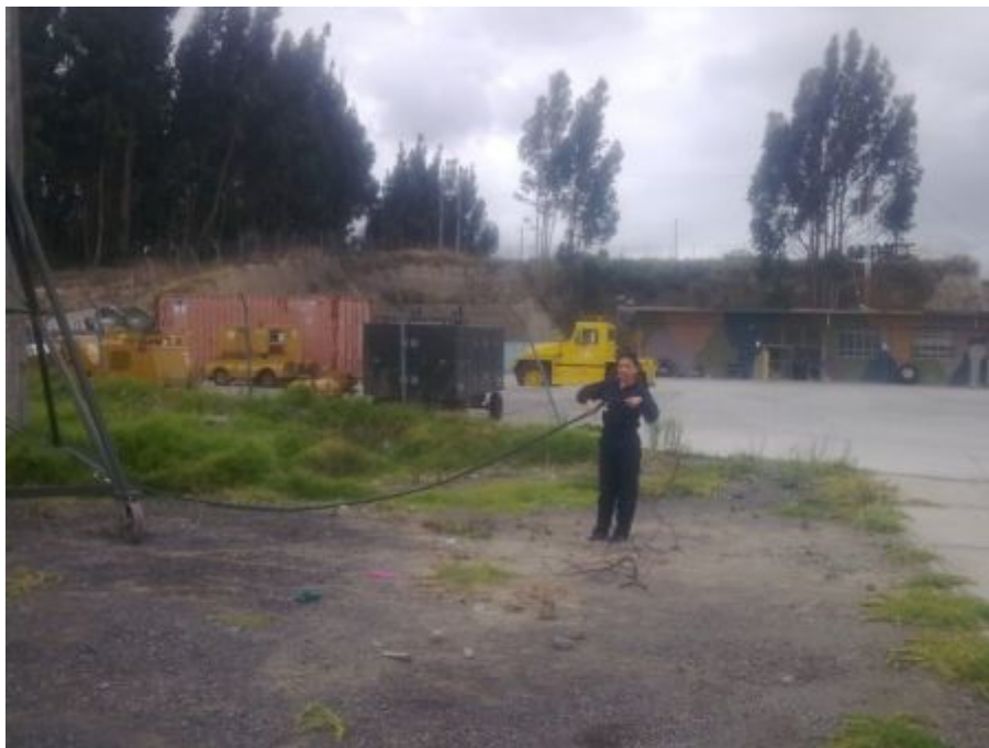
Figura 43. Distribución del cable en la Plataforma Militar
