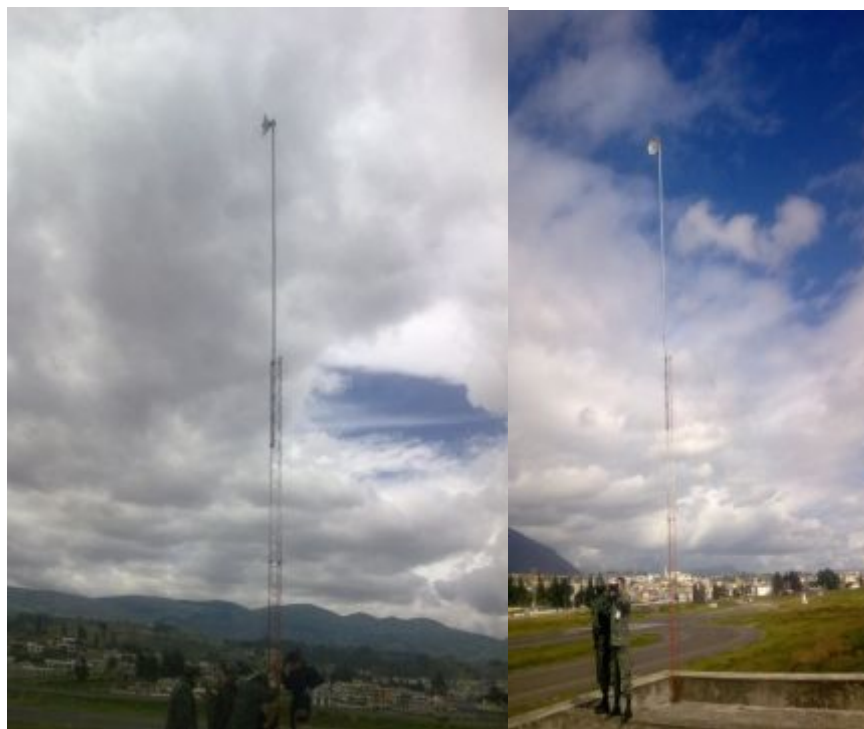
Figura 42. Instalación de la torre con la antena Transmisora
