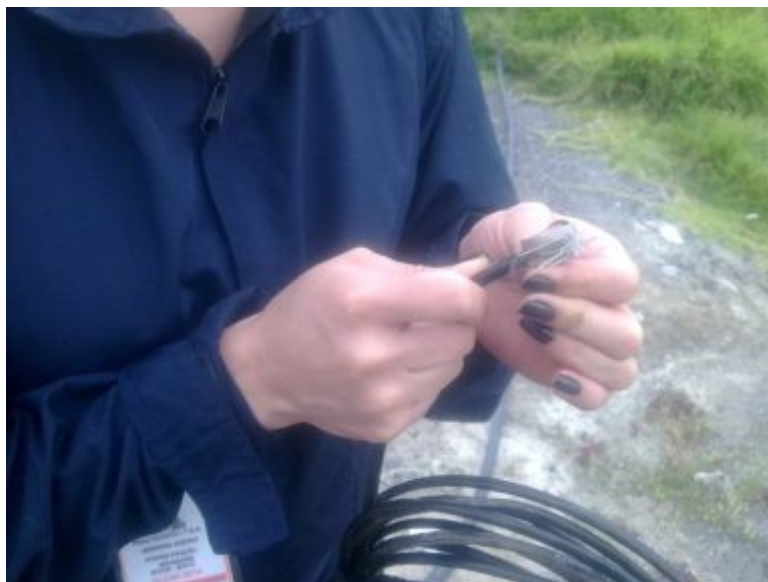
Figura 41. Ponchado del cable con los conectores RJ 45 blindados
