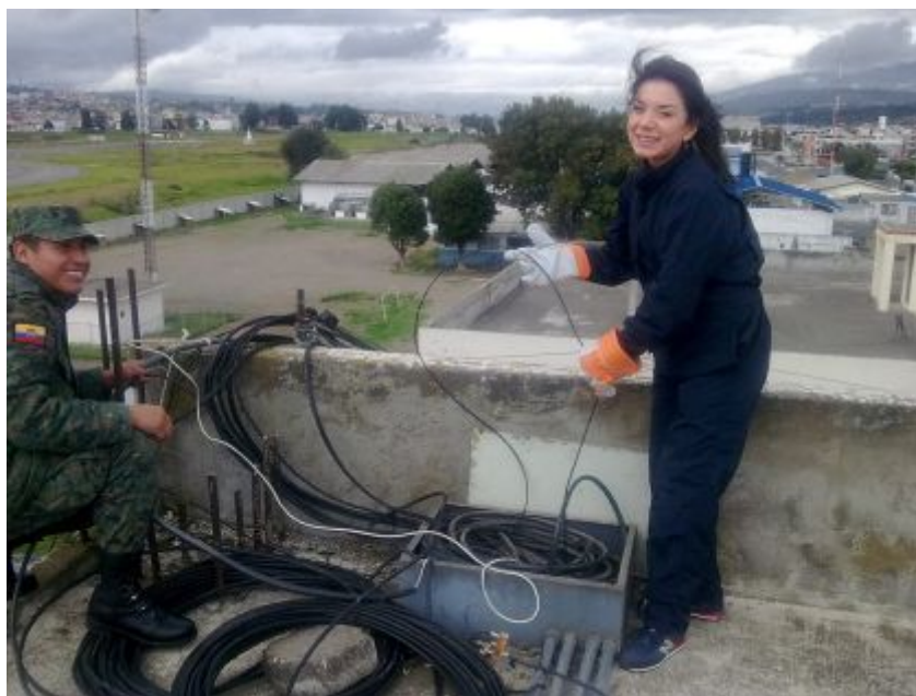
Figura 40. Distribución de cable en el edificio Comando
