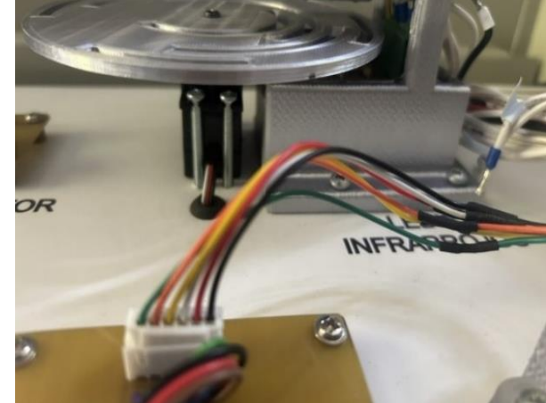
Montaje al tablero
