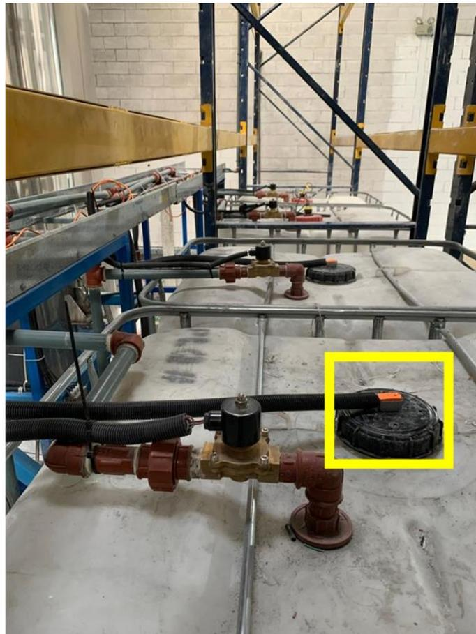
*Nota.* Las fotografías muestran los sensores de nivel en el centro de cada tanque IBC, y las electroválvulas de reabastecimiento.
