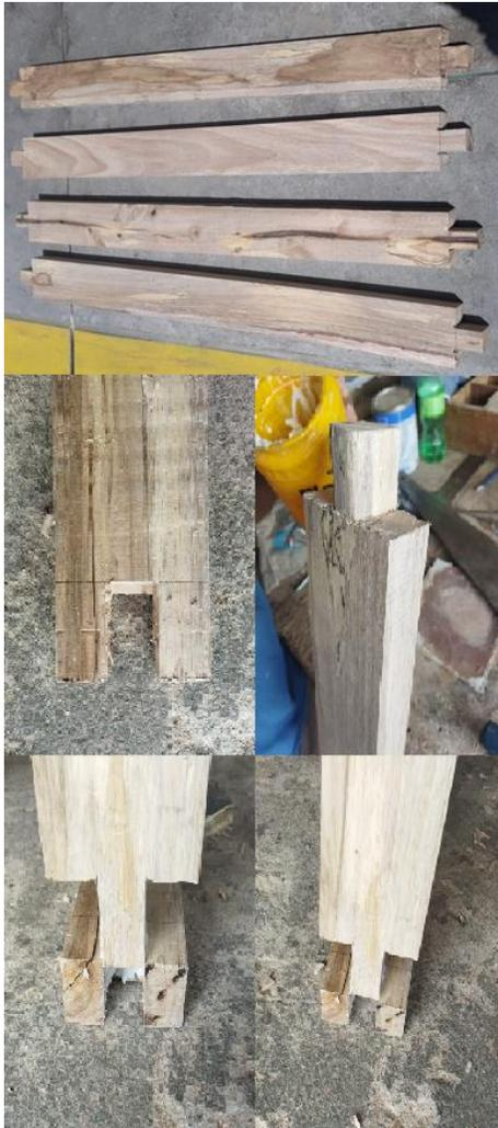
Con la finalidad de obtener una unión estable y fuerte entre columnetas y viguetas que conforman el marco, se realizaron espigas en los extremos de las columnetas, mientras que en los extremos de las viguetas se dejaron los respectivos espacios para que ingresen las mismas.
