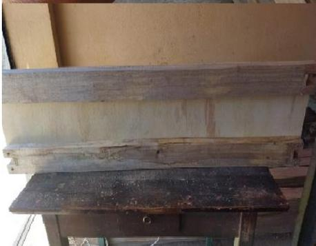
En los lados de los marcos que han sido seleccionados para introducir la paja, se construyen tapas que son desmontables y que se colocarán de manera definitiva hasta rellenar completamente el panel con este desecho agroindustrial. Para la construcción de las mismas, las viguetas se deberán unir con los tableros mediante tornillos de 4 mm de diámetro y 50 mm de longitud que son ubicados de forma paralela en los extremos y en el centro de cada vigueta, con la finalidad de formar un solo elemento.
