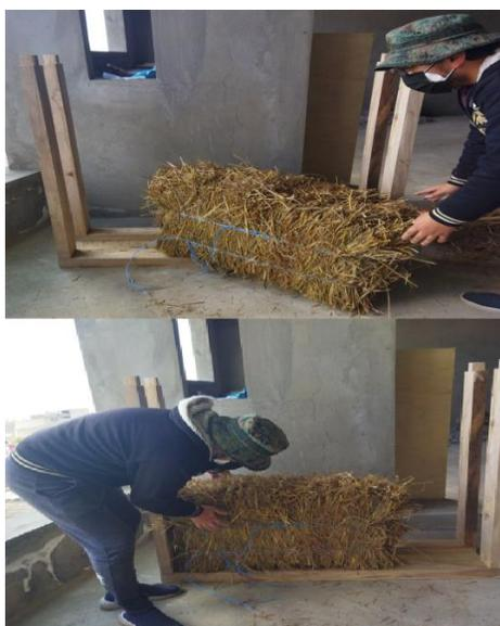
Para iniciar el proceso de relleno, el marco se colocará en una superficie completamente recta y sin la tapa superior. Una vez en esta posición sobre la tapa inferior y dentro del marco se ubicará un fardo pegado a una de las esquinas del mismo, para completar el relleno de la primera fila se cortará un fardo a la mitad donde será cosido para evitar que se desarme.
