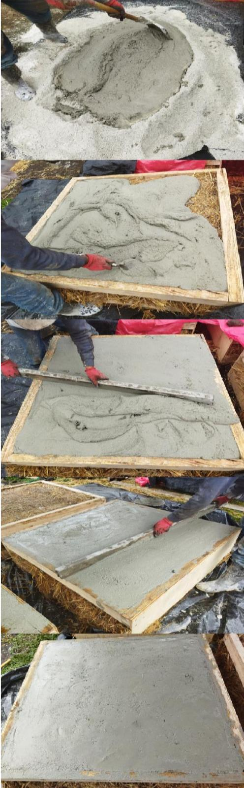
Una vez que la malla metálica haya sido instalada en el panel se procederá a colocar el mortero de recubrimiento elaborado con la mezcla 5050AM2. Primero se deberá determinar la dosificación correspondiente que permita encontrar las cantidades de agua, cemento, perlita, cal, aditivo para obtener el mortero necesario que recubra una de las caras de todos los paneles fabricados.
