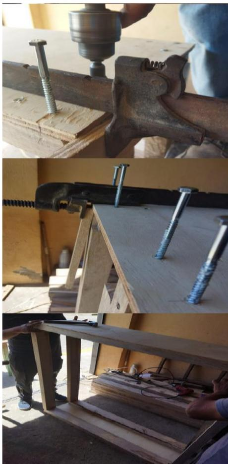
Las tapas deberán ser colocadas sobre los marcos secundarios que están separados entre sí 35 cm medidos desde los bordes externos, posteriormente se procede a instalar de forma paralela y alineados en una sola fila dos tornillos de 8 mm de diámetro y 120 mm de longitud en cada una de la esquina del marco y sobre los tableros.
