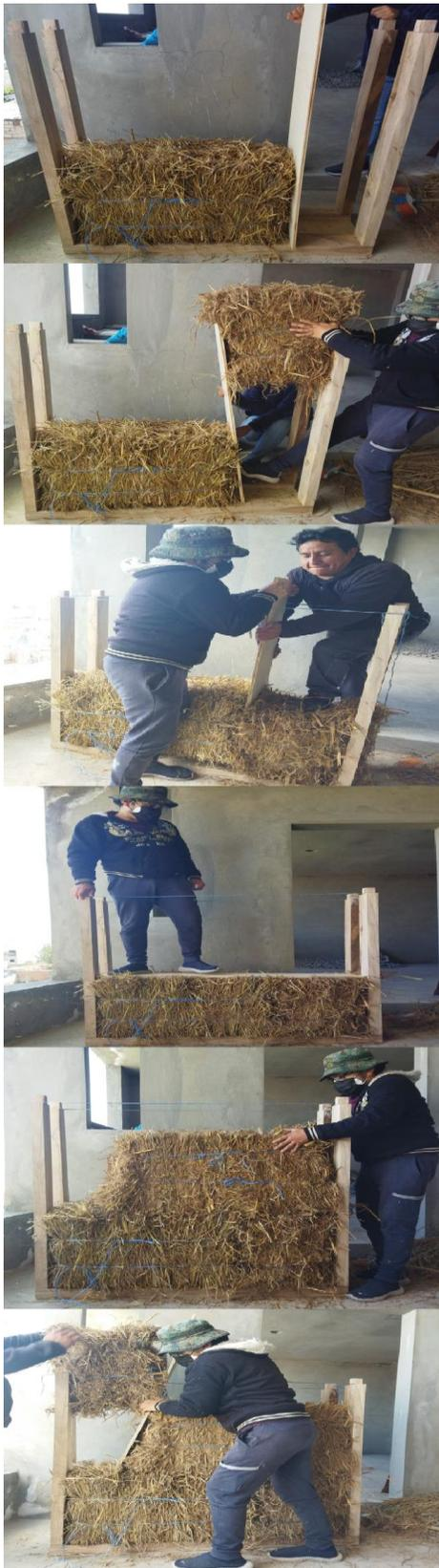
Posteriormente con ayuda de un tablero dispuesto de forma vertical y colocado entre el fardo completo y el espacio aun sin rellenar, se introducirá la mitad del fardo haciéndolo resbalar sobre el tablero e ingresándolo a presión con las manos y pies, el tablero se deberá retirar cuando se haya rellenado completamente la primera fila.
