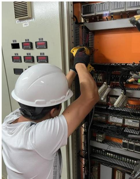
En base a las consideraciones de diseño del Apéndice F se realizó la adecuación en el doble fondo del tablero CLP 1 para el montaje del Rack BMEXBP1200, como se muestra en la Figura 87.
