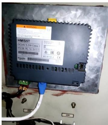
En la Figura 92 se muestra la conexión de la pantalla HMI por el nuevo medio físico a través de cable Ethernet.
