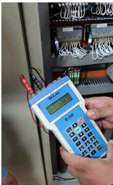
Durante el proceso del comisionado de señales existió inconsistencias en algunas señales de sensores de campo, por lo que se verificó en los planos de los tableros CLP 1 y CLP 2 el trayecto de las mismas. Basándose en los planos se verificó que el inconveniente fue a raíz de un fusible del bus de campo, el cual fue sustituido correspondientemente a los valores establecidos en la guía técnica.
