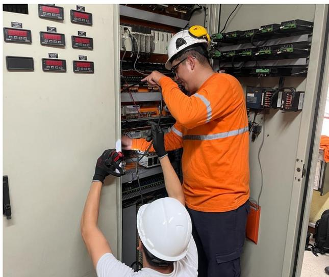
En la Figura 86 se muestra la desconexión de los accesorios terminal a tornillo de 20 puntos y los accesorios conector a telefast, de este último es retirado todo el cable de la canaleta hasta el módulo telefast ABE 7.
