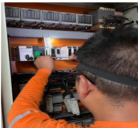
Se desconectó los terminales de las E/S digitales y se inspeccionó el estado de los terminales, tanto el ponchado como el cable. A continuación, se conectó los terminales al nuevo accesorio terminal de 20 puntos, como se muestra en la Figura 89.
