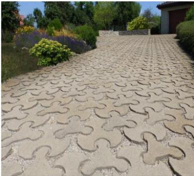
Este sistema puede adaptarse a terrenos irregulares. Su forma recibe el nombre de "tri-lock" debido a sus tres lados hembra y tres lados macho.
