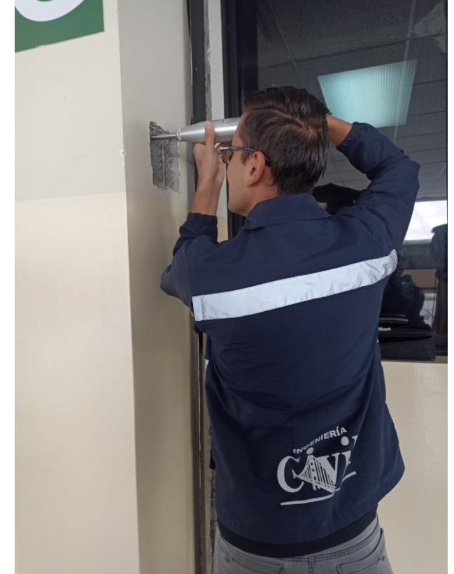
Bloque central entre los Bloques C y D
