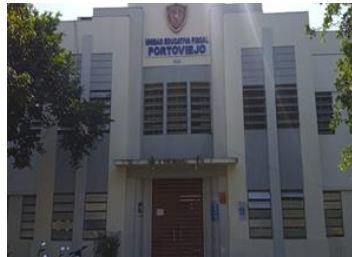
E16 Edificio de aulas y oficinas Tipo MX 30 años de construcción
