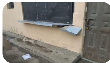
Estado de Conservación de la Edificación
