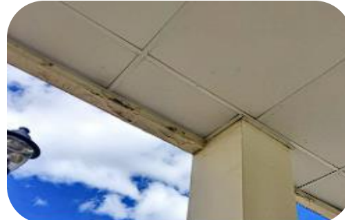
Elementos no estructurales exteriores
