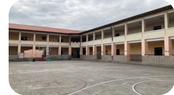
E7 Tipo C3 Año de construcción (1977)
