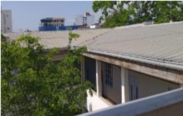
Estado de Conservación de la Cubierta
