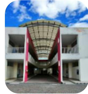
Estado de conservación de la cubierta
