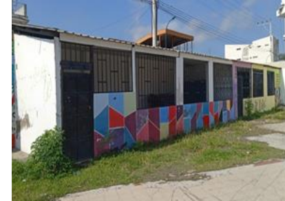
E8 Edificio de aulas Tipo S5 9 años de construcción Esquinas reentrantes
