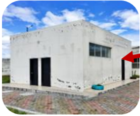
E4 Edificio de aulas Tipo C3
