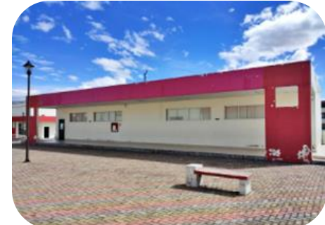
Estado de conservación de la edificación
