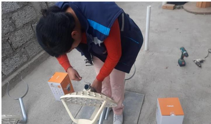
*Nota.* Se coloca las 3 antenas CPe Mikrotik LHG5 en cada una de las estructuras con las respectivas cajas para la energía.
