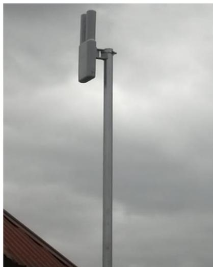
*Nota.* Se procede a realizar la colocación de la antena Ap Ominitk en el sitio específico para la transferencia de datos de las tres antenas Cpe Microtik LHG5.
