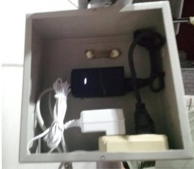
*Nota.* En cada una de las cajas se procede a colocar la conexión eléctrica tanto para las cámaras como para la antena, mediante el POE se conecta para energizar a la antena y el puerto LAN para la conexión con la cámara.
