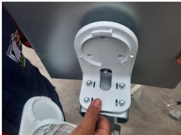
*Nota.* Las bases de las cámaras van atornillada a la basa de la estructura del brazo de la antena, este proceso se lo realiza en las tras bases.
