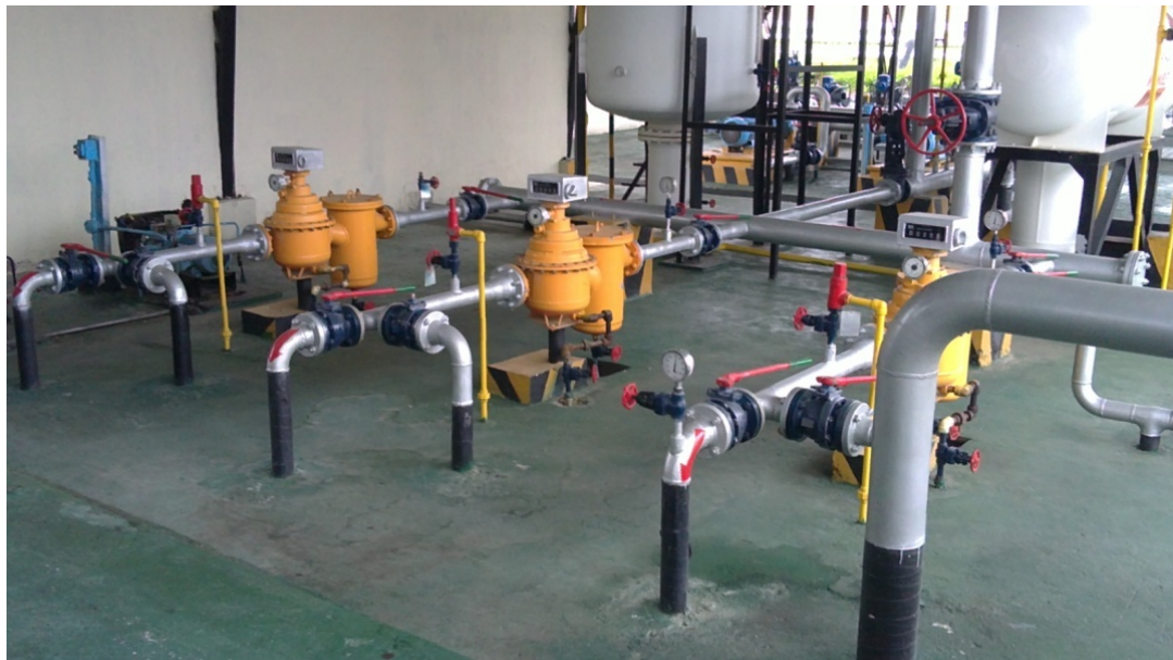
Figura 1.6. Patines de Medición de Desplazamiento Positivo
