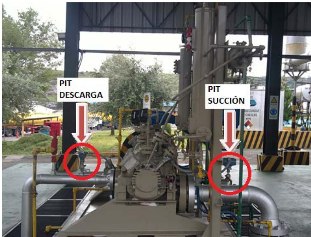
Figura 3.15. Ubicación PITs del Grupo de Bombeo Eléctrico
