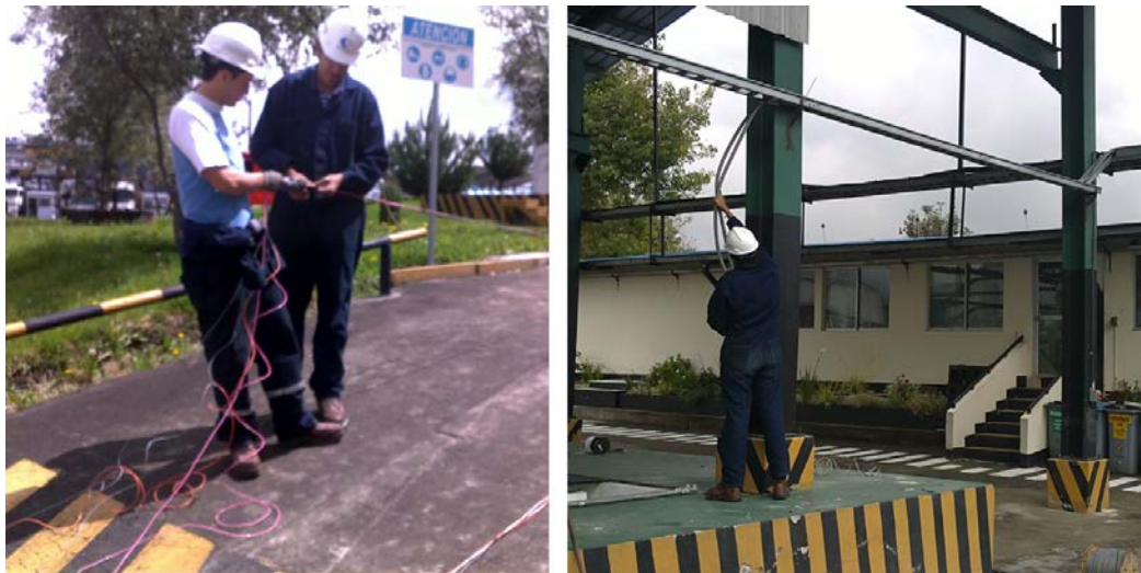
Figura 4.24. Instalando cable sobre Canaleta
