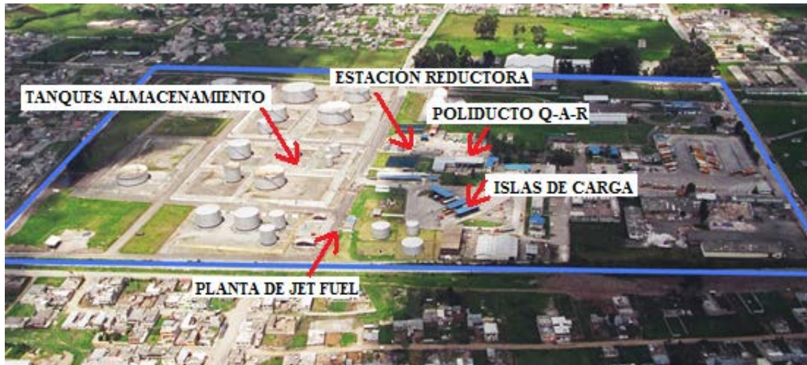
Figura 1.2. Vista general Terminal "El Beaterio"
