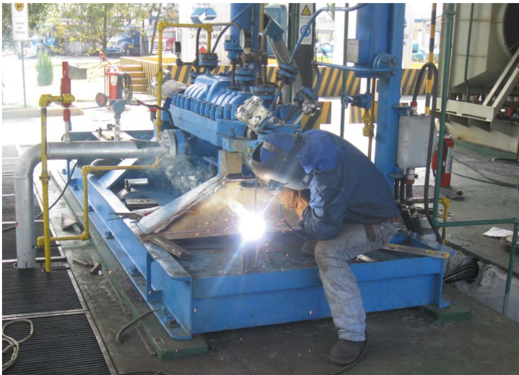
Figura 4.14. Refuerzo Base de Bomba
