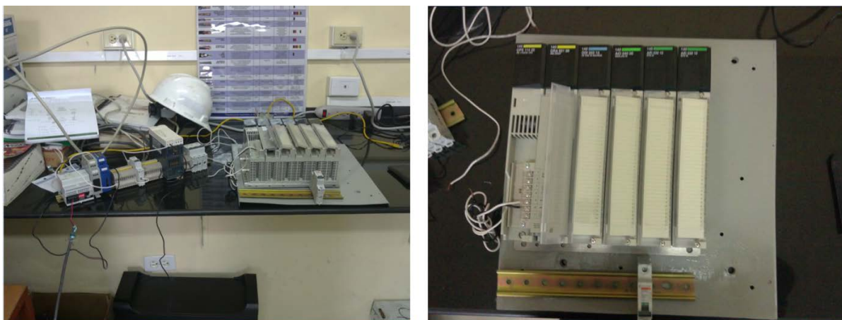
Figura 4.26. Armado del Backplane Secundario
