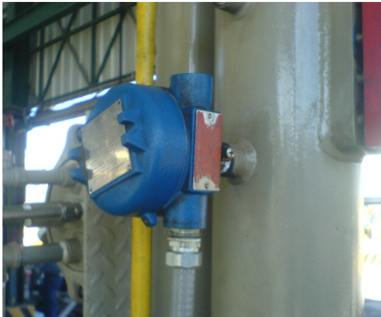
Figura 3.17. Sensor de Nivel Magnetrol
