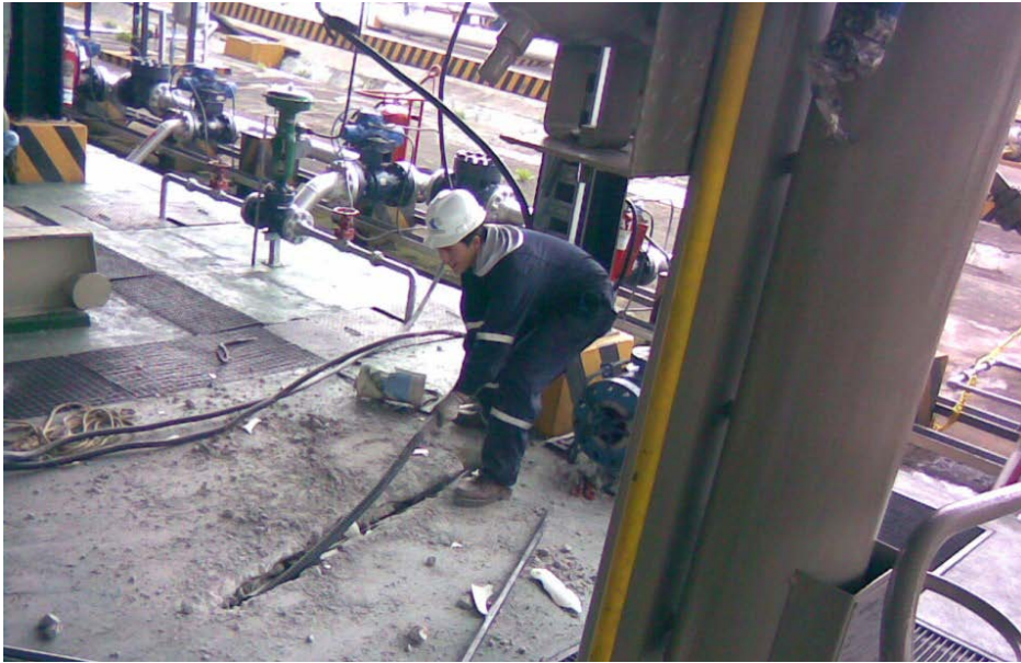
Figura 4.18. Remoción de Cable Armado
