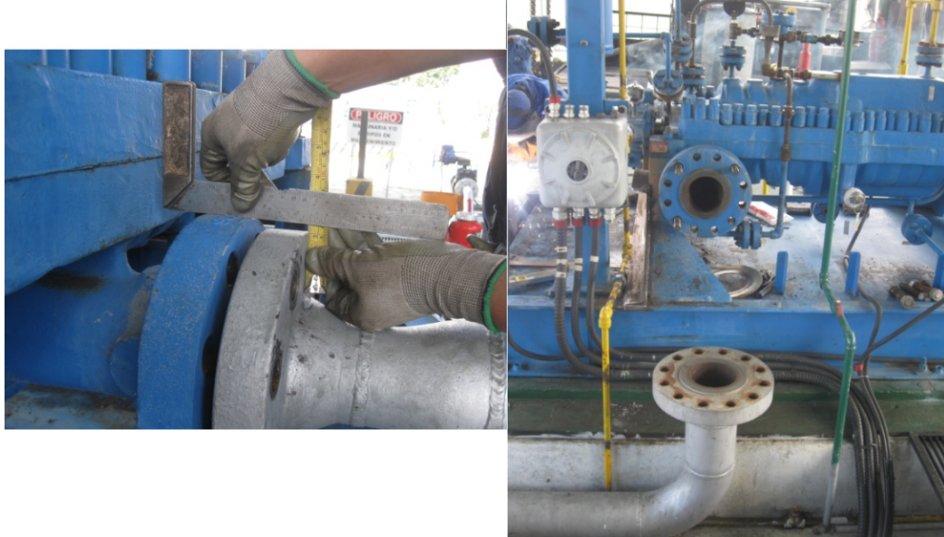
Figura 4.15. Alineación de Tubería
