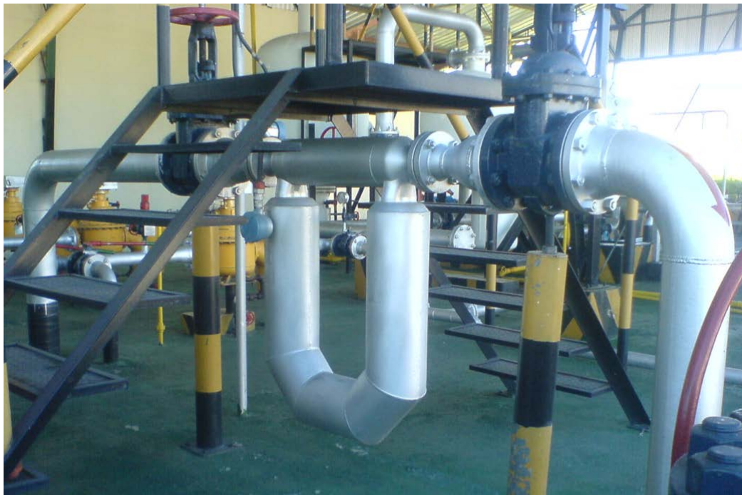
Figura 3.19. Medidor Másico Coriolis
