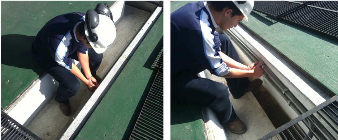
Figura 4.23. Instalación de Tubería: Comunicaciones y Alimentación
