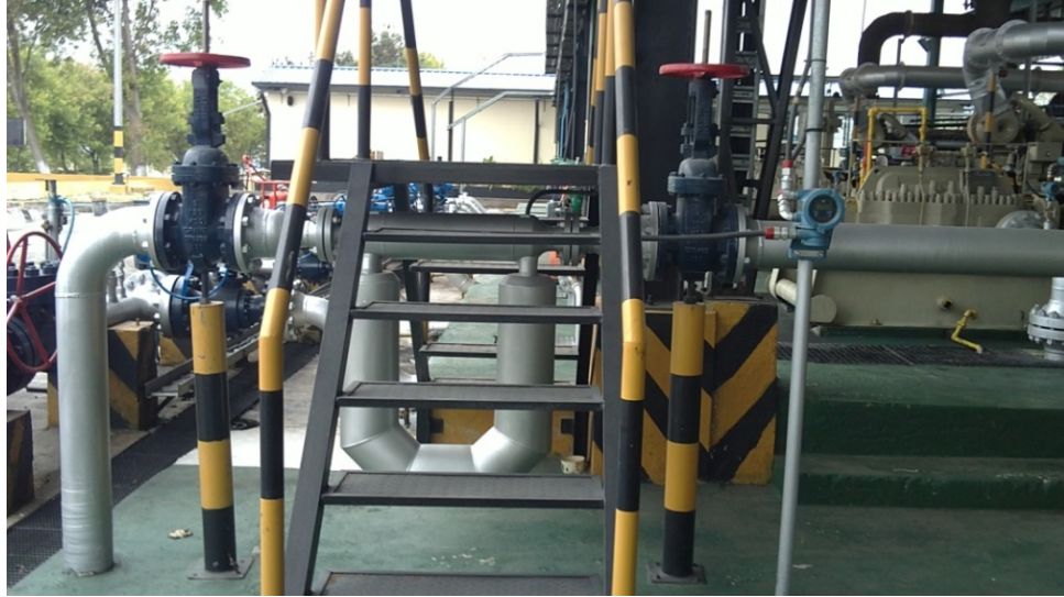
Figura 1.7. Medidor Másico Tipo Coriolis
