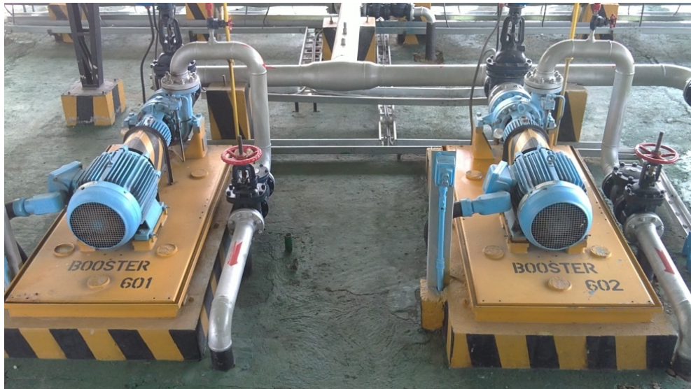
Figura 1.4. Bombas Booster
