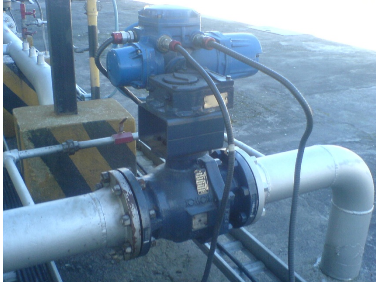
Figura 3.10. Válvula de Bola Succión
