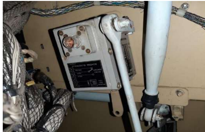
Inspección del freno magnético
