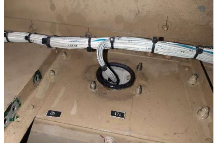
Inspección del cableado del sistema
