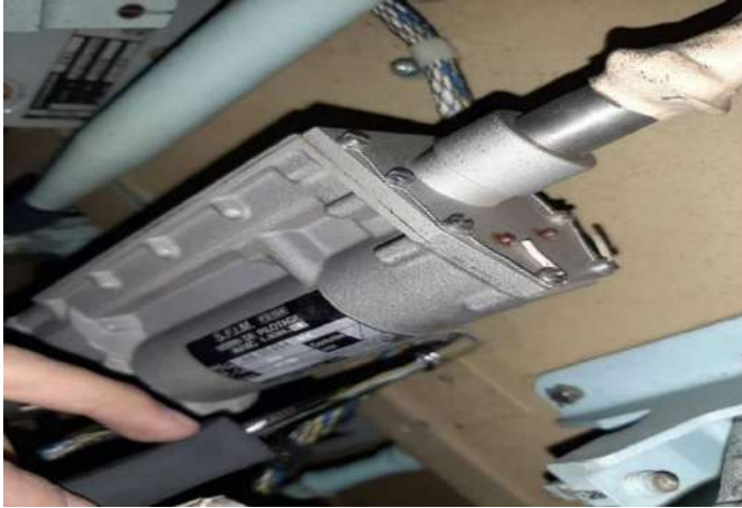
Inspección de los jacks lineales
