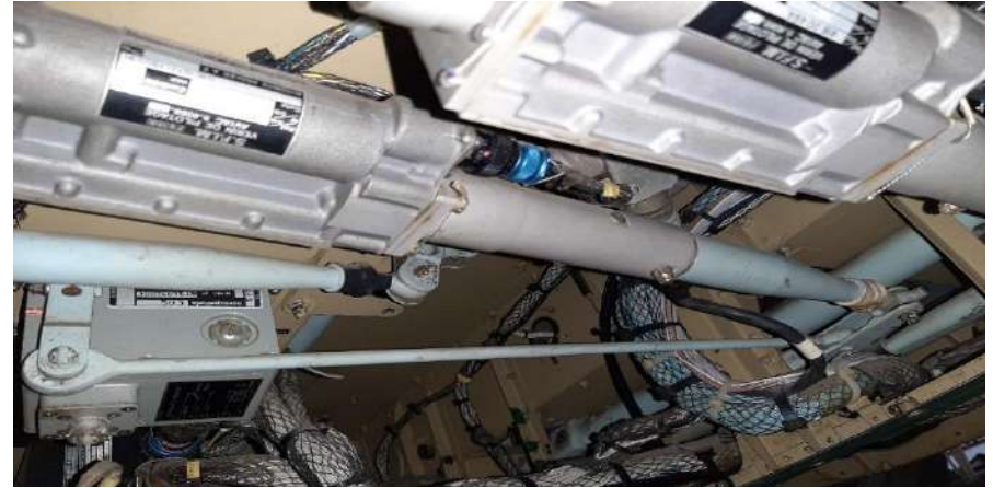
Verificación del espacio entre varillas y componentes fijos
