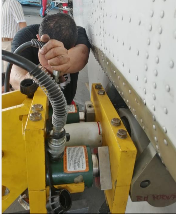
INSTALACIÓN DE SPRING PULLER
