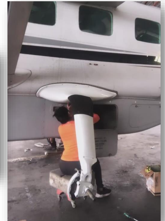
INSTALACIÓN DE CARENADOS
