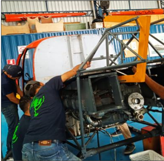
Soporte del izado del motor
