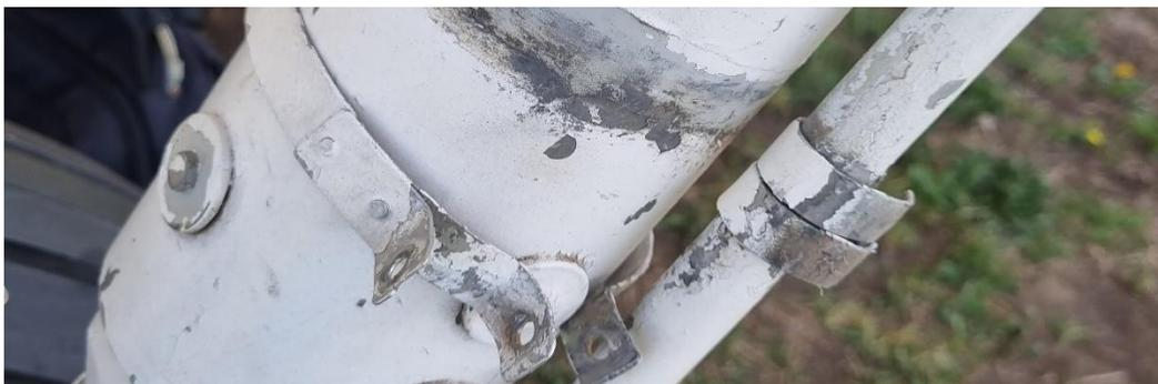
Posteriormente las abrazaderas removidas se procedieron a dar mantenimiento, lijando las partes con corrosión, y removiendo la pintura para que con la ferretería nueva que será la intercambiable por la antigua, se sometían a un proceso de pintado. En principio se ubicó los componentes sobre una superficie limpia y plana para que durante el pintado no exista problemas después se le sometió al pintado con primer como base de la pintura.
