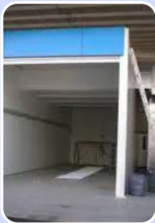
Cabina de pintura
