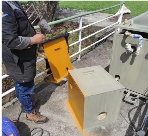
*Nota.* Es importante recalcar que se aplicó la segunda capa de pintura color amarillo Caterpillar mediante el uso del compresor a toda la estructura.
