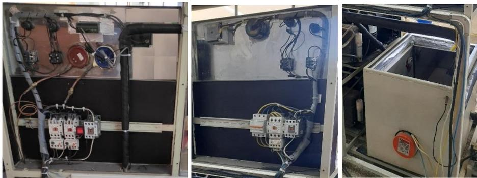
Por esta razón se implementó el tablero de control, para ordenar adecuadamente los cables por medio de canaletas en el caso que se requiera realizar una modificación o cambio como se observa en la figura 79.
