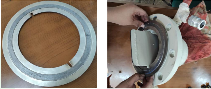
Figura 26 Colocación de los empaques bimetálicos
