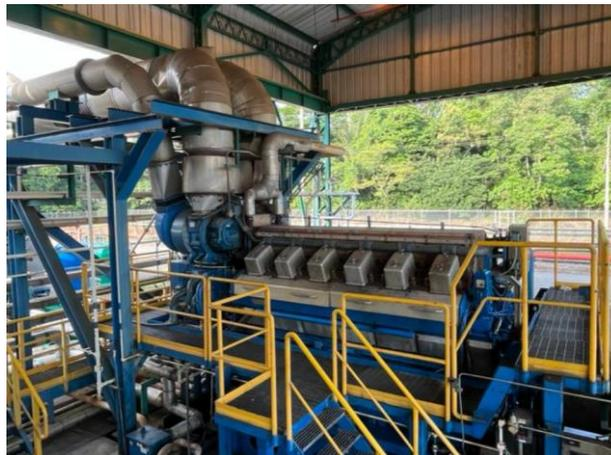
**Descripción.** Es un motor de 4 tiempos, turbocargado, con intercooler. Estos motores se utilizan principalmente en aplicaciones como: propulsión de buques de gran tamaño, generación de energía eléctrica o suministrando energía mecánica para accionar bombas en el transporte de hidrocarburos.
