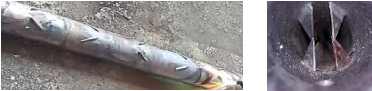
Soldadura de aletas D1
