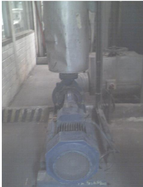
**Figura. II.40. Bomba de recirculación de agua del caldero**
