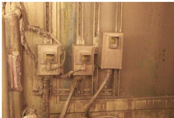
Figura. II.15. Equipos cubiertos con pintura
