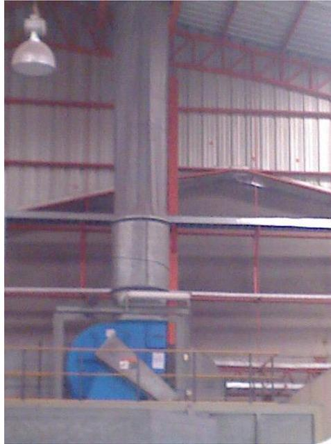
**Figura. II.35. Extracción de aire – Ventilador extractor**
