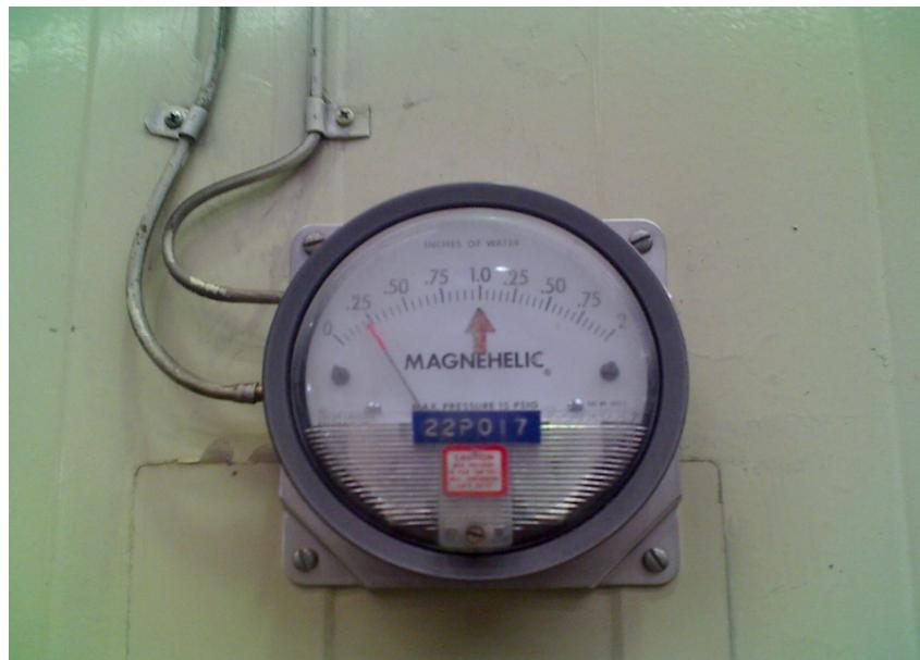
Figura. III.8. Sensor diferencial de presión – filtros de quemadores
