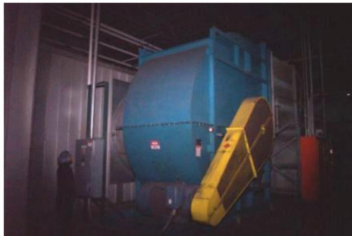
**Figura. II.43. Ventilador impulsor de aire**
