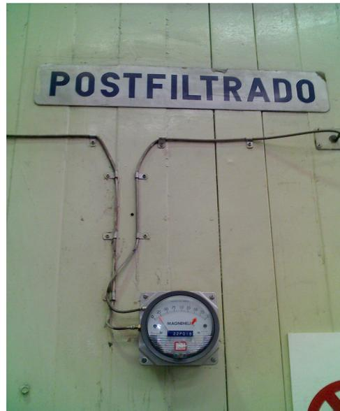
Figura. III.7. Sensor diferencial de presión – filtros secundarios
