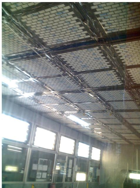
**Figura. II.33. Techo de cabina – filtros de plenum**
