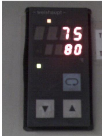
Figura. III.4. Controlador de quemador
