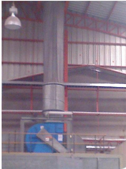
**Figura. II.44. Ventilador extractor de aire superior**
