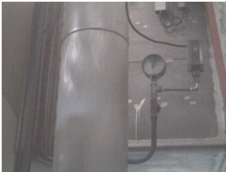
Figura. III.5. Sensor de presión de recirculación de agua de caldero
