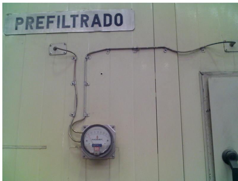
Figura. III.6. Sensor diferencial de presión – filtros primarios
