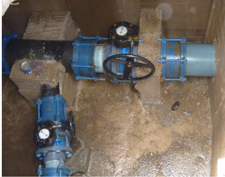
Figura 2.19. Nodo (C-DV)6 Válvulas Mariposas
