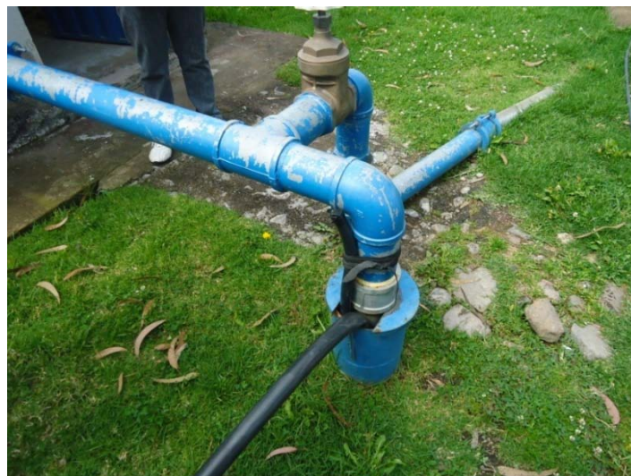
Figura 2.6. Perforación Estación de Bombeo Cashapamba
