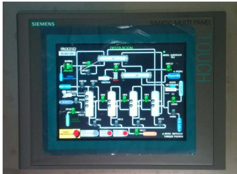
Figura 6. 31. Apertura y cierre de las electroválvulas en la HMI
