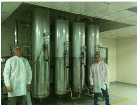
**Figura 1. 5. Área de inyectables: Destilador de Agua QV 2000 marca OLSA**
