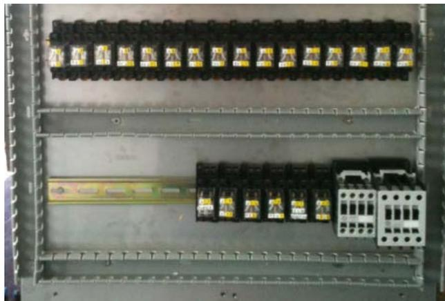
**Figura 5.25. Relés de protección y contactores**
