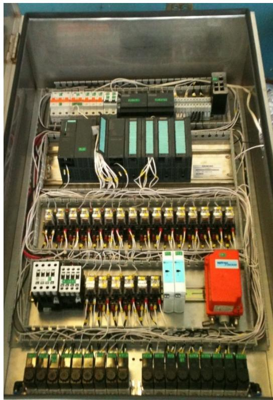
**Figura 5. 33. Dispositivos y cableado del armario correctamente etiquetado**
