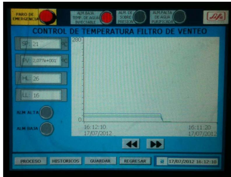
Figura 6. 34. Verificación del funcionamiento del Controlador ON/OFF de Temperatura
