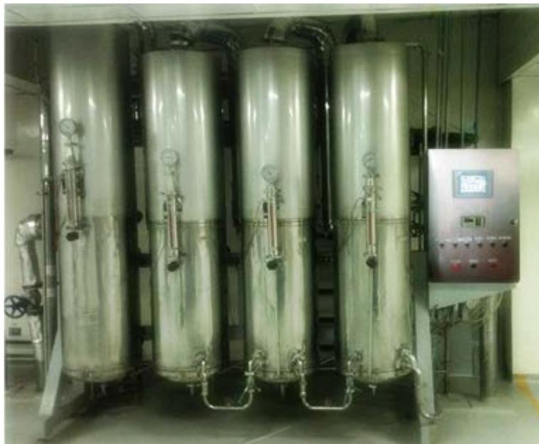
**Figura 5. 46. Nuevo sistema de monitoreo, supervisión y control del proceso de destilación de agua**
