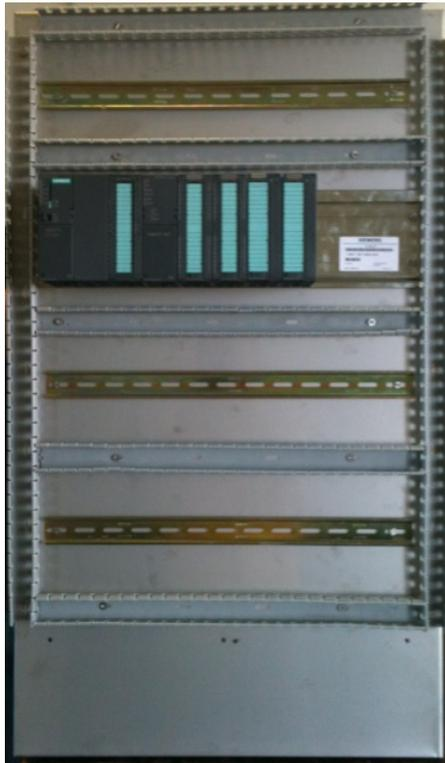
Figura 5. 23. Tablero con rieles DIN y canaletas
