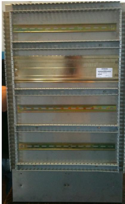
**Figura 5. 22. Canaletas implementadas en el armario**
