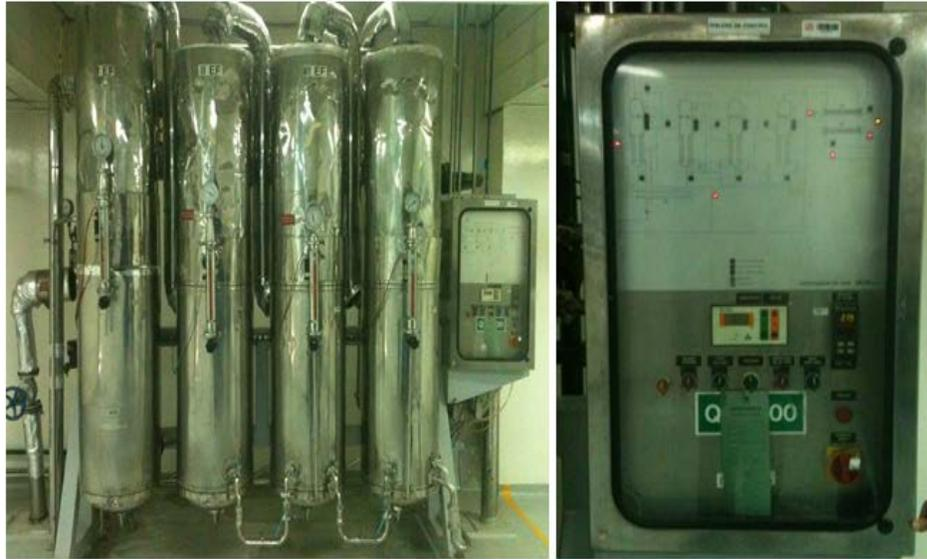
**Figura 5. 18. Destilador OLSA QV-2000 junto al armario del proceso de destilación de agua**
