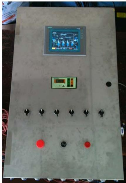
**Figura 5. 41. Parte frontal del armario con todos sus elementos**
