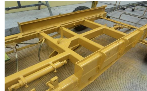
Proceso de pintura
