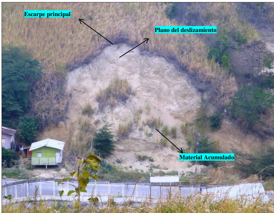
Imagen 2.2. Deslizamiento Rotacional sector
