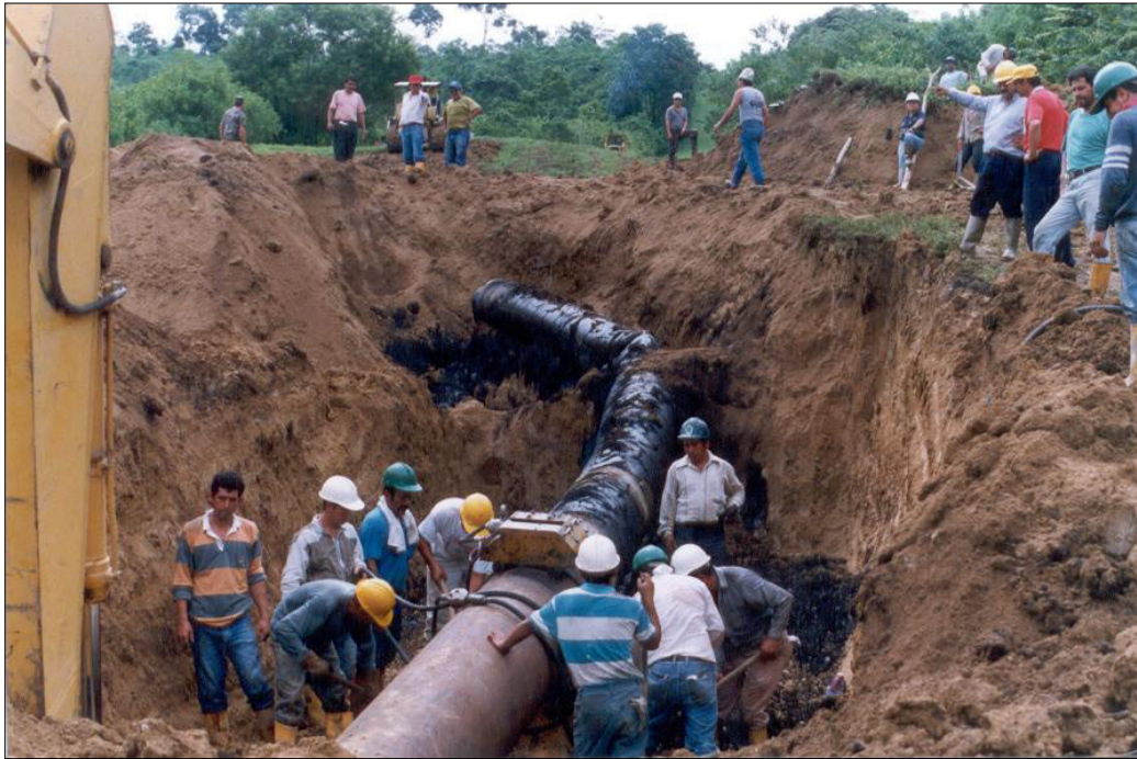
Imagen 1.2. Rompimiento de tubería del SOTE por deslizamiento
