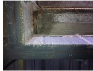
**Soldadura filete (conexión viga principal - viga secundaria)**
