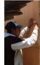
Figura 29.: Construcción de la cabina.
