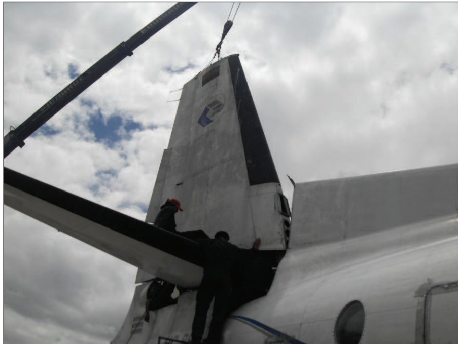
Figura B.1: Desmontaje del estabilizador vertical. Fuente: Investigación de campo.
