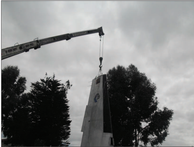
Figura 3.24: Elevación del estabilizador vertical.
