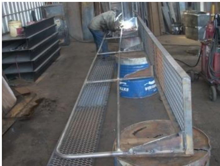
Fotografía 23: Soldadura en la Construcción de Corredores
