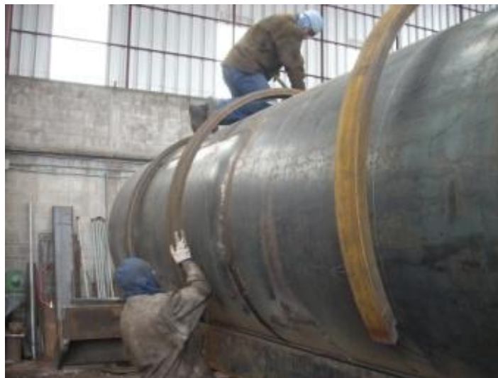
Fotografía 35: Colocación de Refuerzos UPN Alrededor del Tanque
