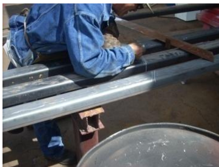
Fotografía 12: Corte de los Refuerzos de los Espejos
