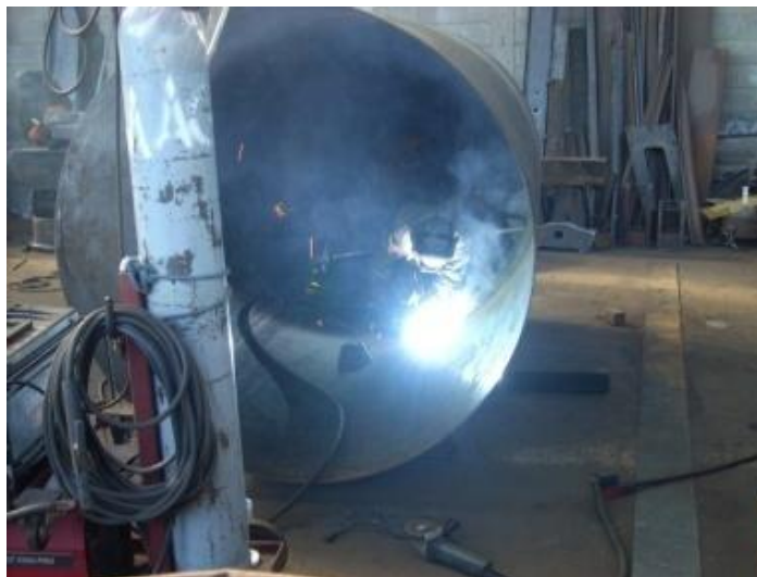
Fotografía 9: Soldadura AFCA en Unión de dos Cilindros
