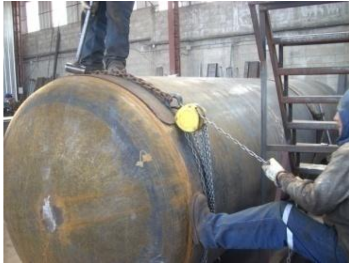
Fotografía 19: Unión con Cadena Refuerzo Base-Cuerpo del Tanque 19
