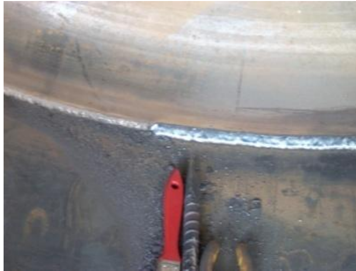
Fotografía 7: Cordones de Soldadura al Interior del Tanque
