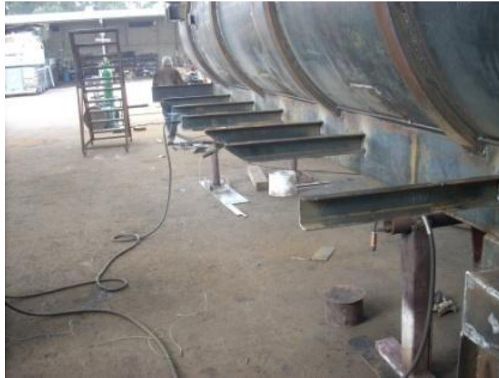
Fotografía 37: Bases de Bandejas Soldadas al Tanque
