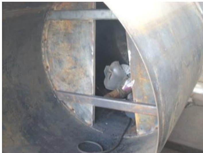
Fotografía 15: Soldadura de Espejos y Refuerzos de Espejos
