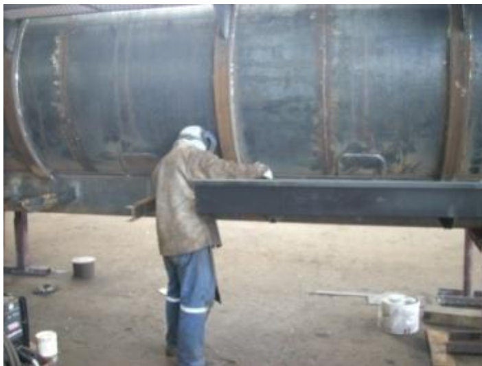
Fotografía 38: Colocación y Soldadura de las Bandejas al Tanque
