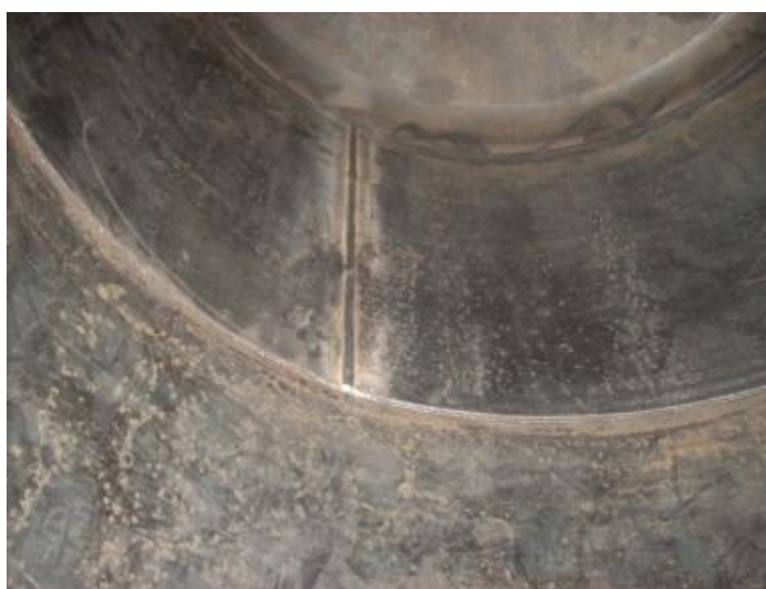
Fotografía 10: Soldaduras Terminadas al Interior del Tanque
