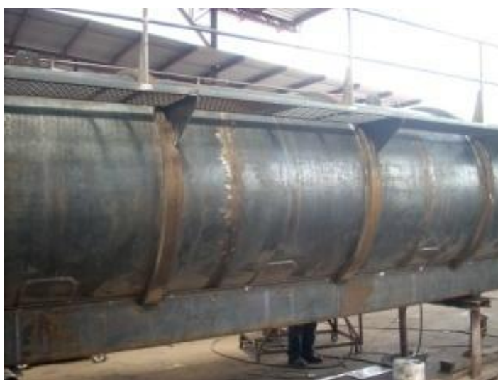
Fotografía 36: Corredor Superior Soldado al Tanque
