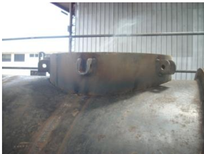
Fotografía 40: Manhole Soldado al Tanque
