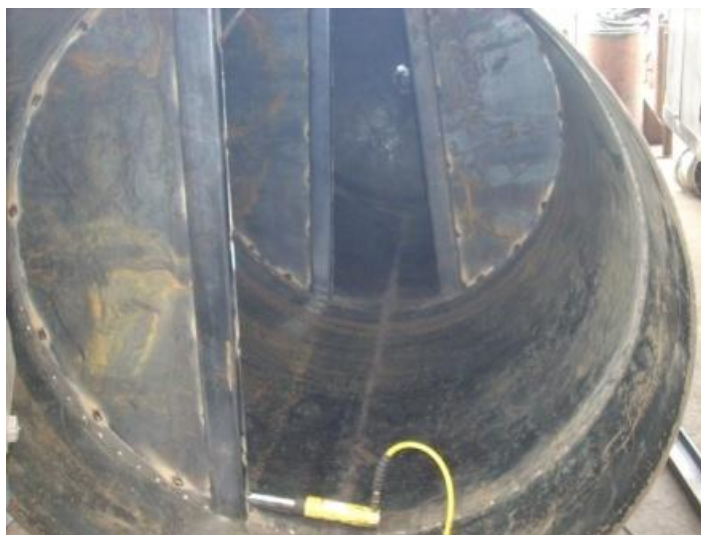
Fotografía 14: Ubicación Refuerzo con Ayuda de Prensa Hidráulica
