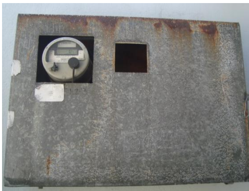
FIGURA 38 CONTADOR DE ENERGIA N° 1
