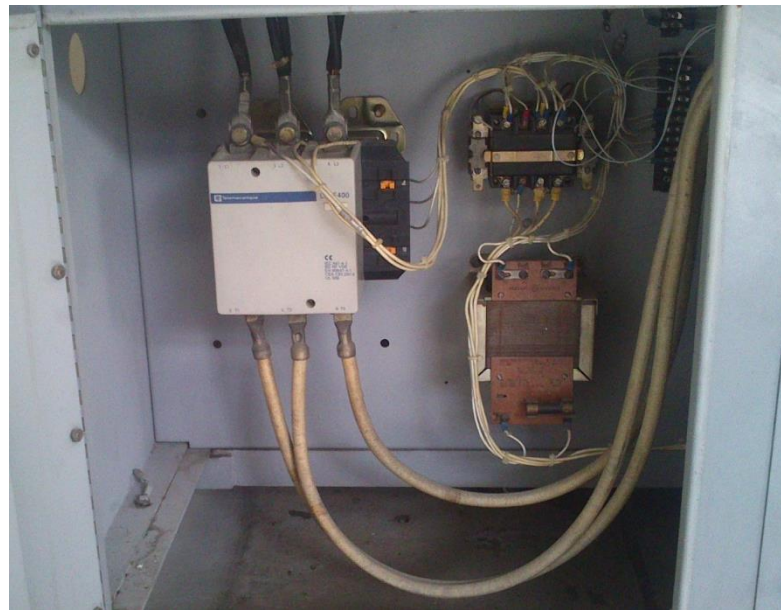
Figura 3.29. Conexión arrancador suave trifásico motor principal.
