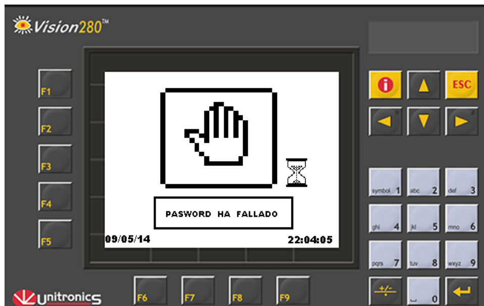
Figura 3.15. Pantalla de seguridad implementada.
