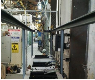
Figura 4 Cubas ubicadas en la estructura
