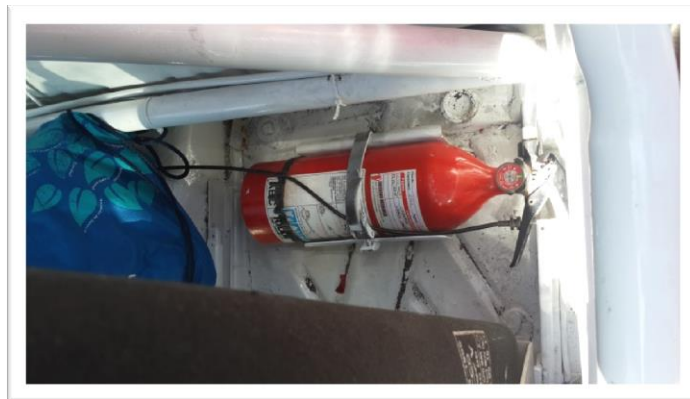
Figura 3.40 Instalación del sistema de extintor centralizado
