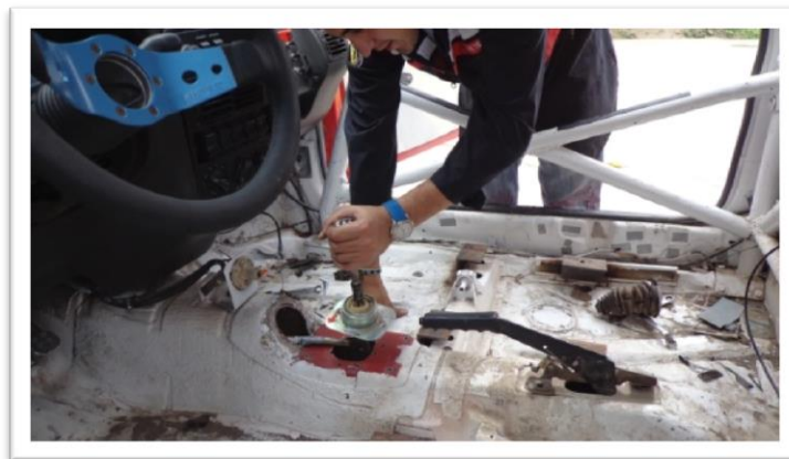
Figura 3.33 Desarme del sistema de cambios original.
