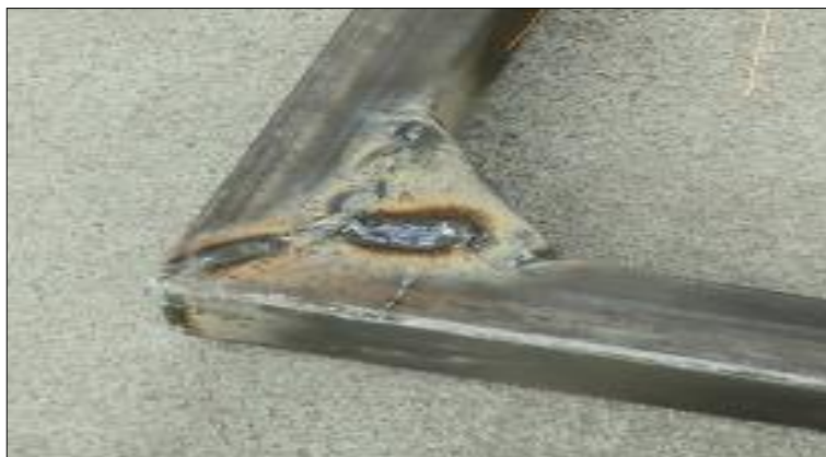
Figura 3.12: Implementación de los esquineros como refuerzos
