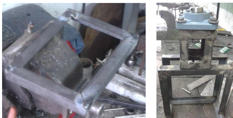
Figura 3.7 Construcción del Soporte Interior y Cuello Mecánico del Robot.
