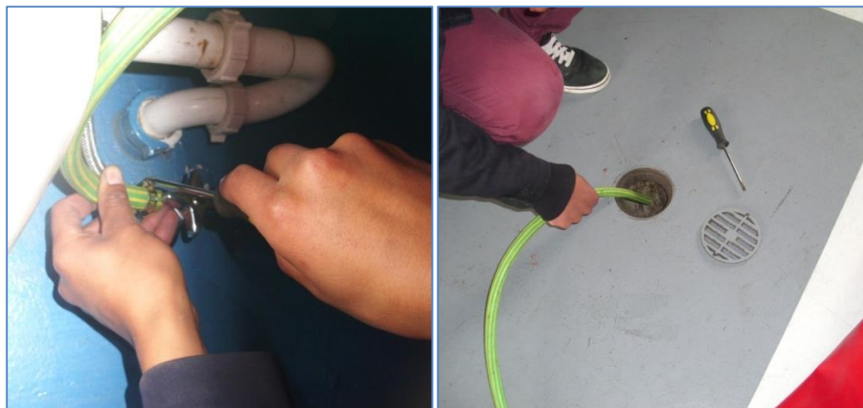
Figura 5. 8 Ajuste y verificación del sistema hidráulico
