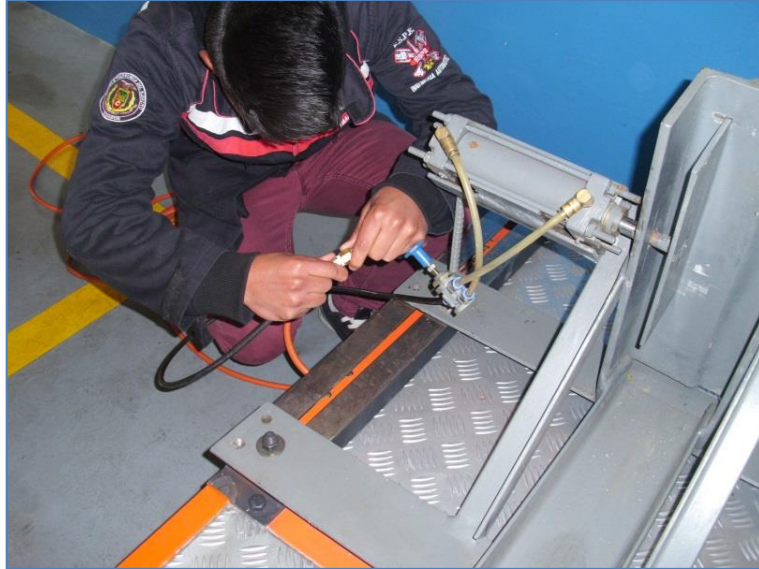
Figura 5. 3 Acople del compresor.
