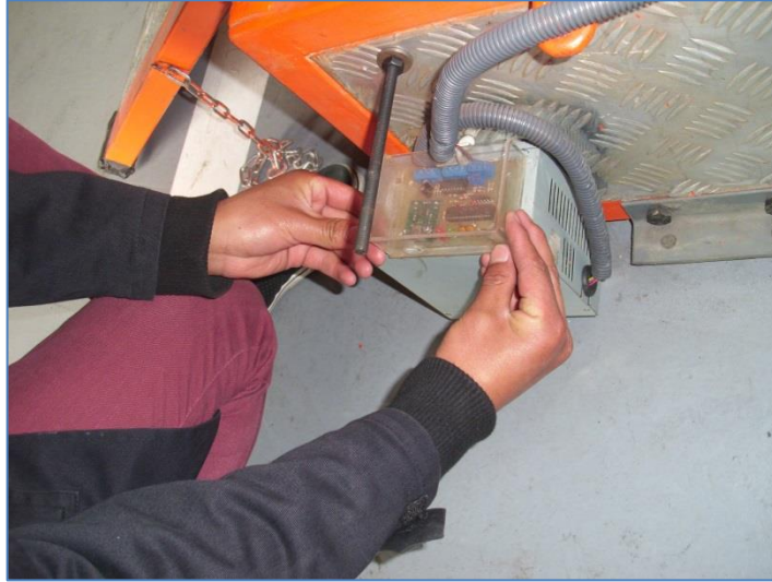
Figura 5. 9 Revisión de la parte eléctrica-electrónica
