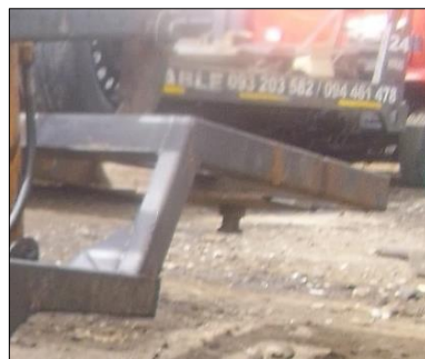
Figura: 4. 11 Instalación del King Pin.
