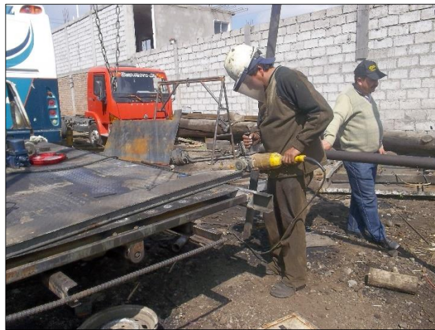
Figura: 4. 4 Doblado y corte del acero estructural.
