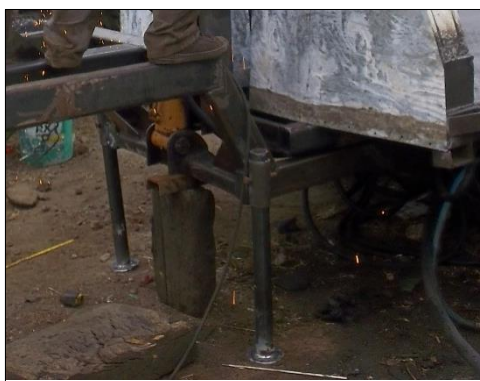
Figura: 4.12 Barras de apoyo dela mini plataforma.
