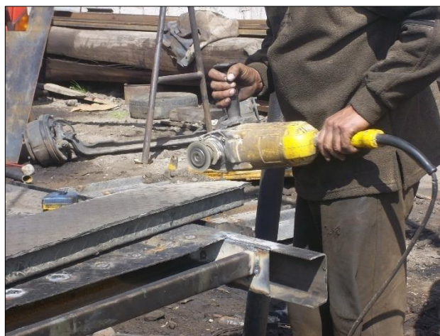
Figura: 4. 9 Perfilado de la estructura.
