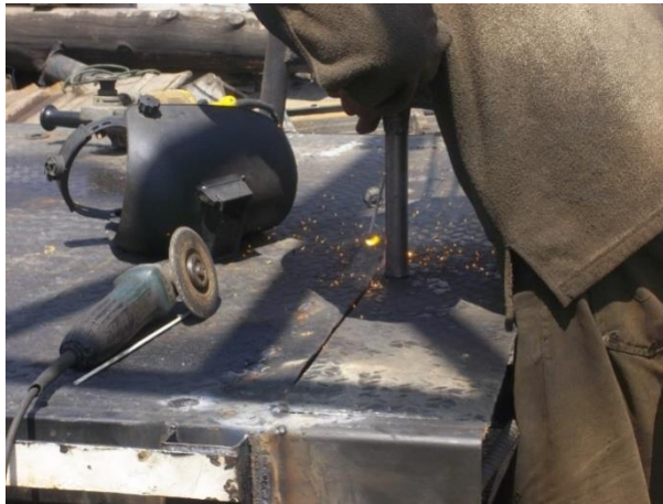
Figura: 4.10 Suelda perfiles de la mini plataforma.
