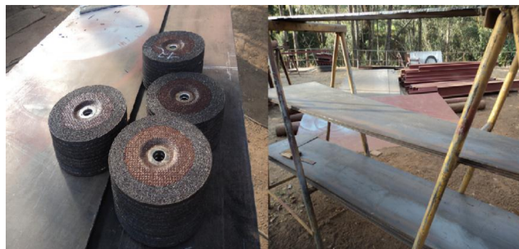
Figura: 4. 3 Proceso de construcción de la plataforma parte hidráulica.
