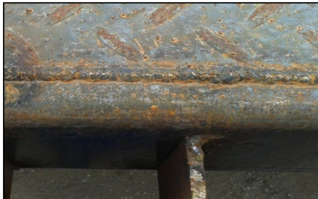
Figura 5.29 Soldadura de plancha corrugada
