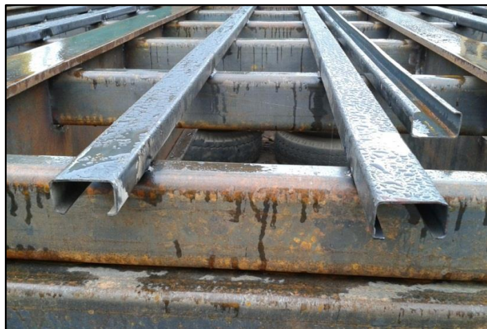
Figura 5.15 Colocación de soportes para plancha
