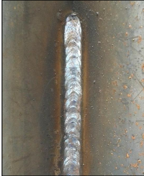
Figura 5.28 Soldadura en la talanquera
