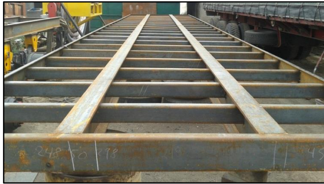
Figura 5.12 Estructura con travesaños y laterales ubicados
