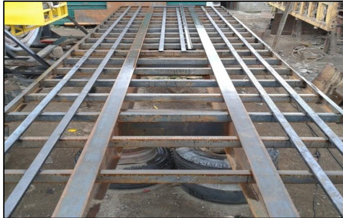
Figura 5.16 Estructura previa a la colocación de las planchas corrugadas
