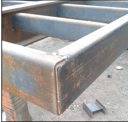
Figura 5.11 Montaje de los travesaños en el larguero
