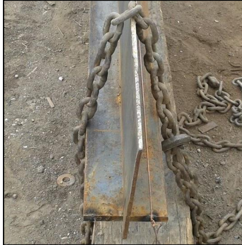
Figura 5.7 Colocación de cadena para fijar la platina en la parte superior de la plancha laminada
