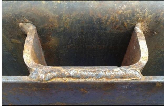
Figura 5.30 Soldadura de sujetadores de carga
