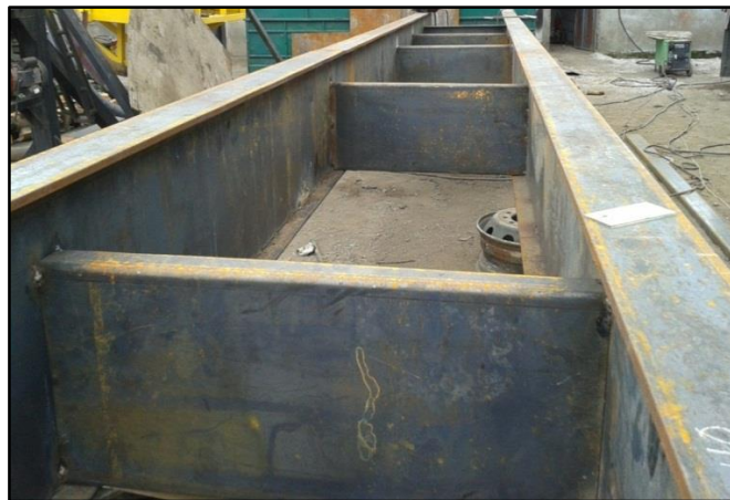
Figura 5.8 Colocación de separadores de largueros
