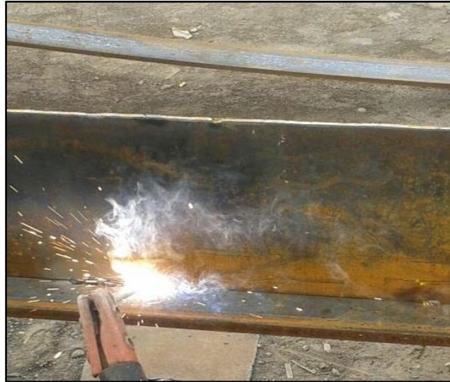
Figura 5.26 Soldadura en el larguero
