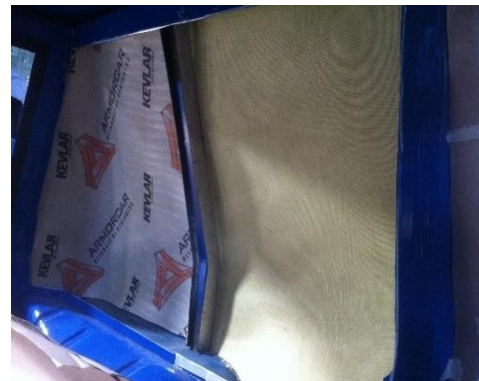
Figura 15: Instalación del kevlar
