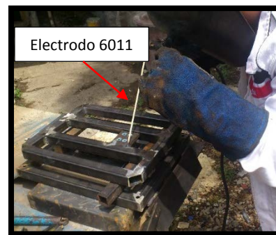
Figura 7. Proceso de solda de platinas de celdas de carga
