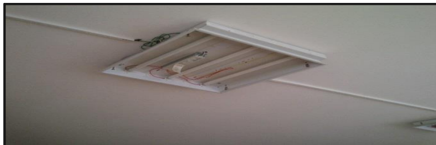
Figura 15. Nuevo cableado en las conexiones de las lámparas fluorescentes
