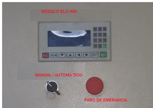
Figura 3. 17 Montaje del módulo ELC HMI, conmutador y paro general
