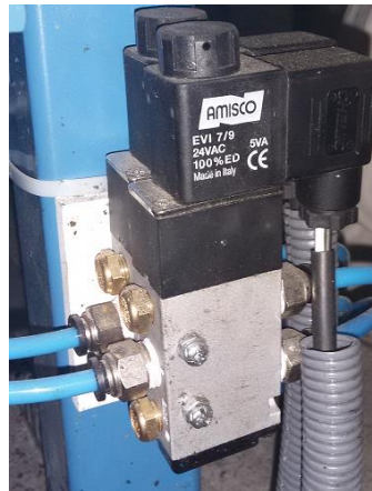
Figura 3. 22 Instalación de las válvulas solenoides
