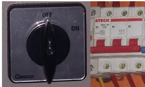
Figura 2. 27 Conmutador de levas de dos posiciones e interruptor termomagnético
