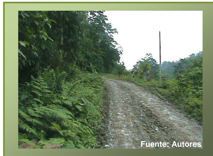
Foto No.12: Infraestructura Vial
