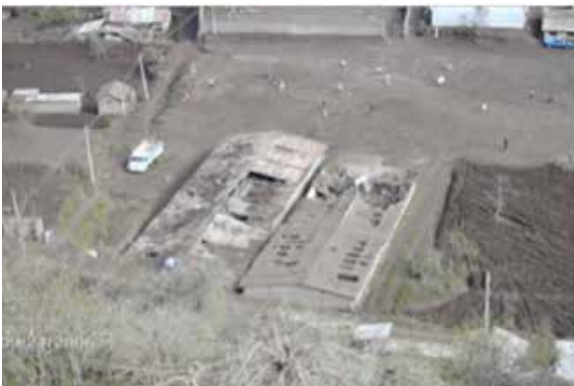
Fig. 6.32, Galpones de San Juan afectados por la caída de ceniza provocando la destrucción de la obra (pérdida total de la inversión). Carlos Vasco
