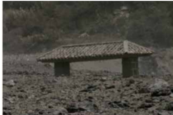
Fig. 6.33, Destrucción total como resultado del flujo piroclástico producido en la ladera del Volcán Tungurahua pérdida de bienes privados Hosterías, moteles, discotecas, lugares de diversión. Foto tomada por la Junta Provincial de Defensa Civil de Tungurahua
