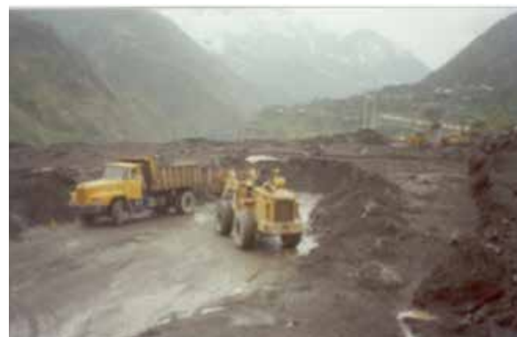
Fig. 6.23, Reparación de vías de acceso a la ciudad de Baños. Carlos Vasco
