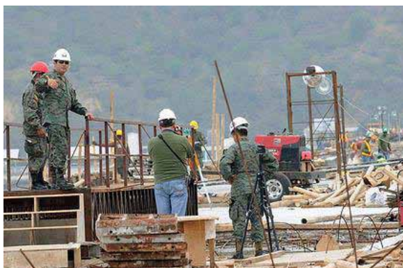
Fig. 6.26, Detrás de numerosos kilómetros de carreteras y modernos puentes que los visitantes admiran en Ecuador está el esfuerzo de una fuerza organizada reconocida por su eficiencia: el Cuerpo de Ingenieros del Ejército. De www.andes.info.ec
