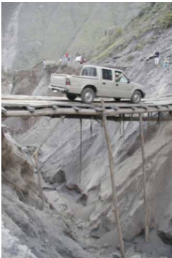
Fig. 6.11, Improvisación de puentes para sortear la dificultad geográfica después de que el flujo piroclásticos del volcán Tungurahua destruyó todos los puentes en la parte del flanco occidental. Carlos Vasco
