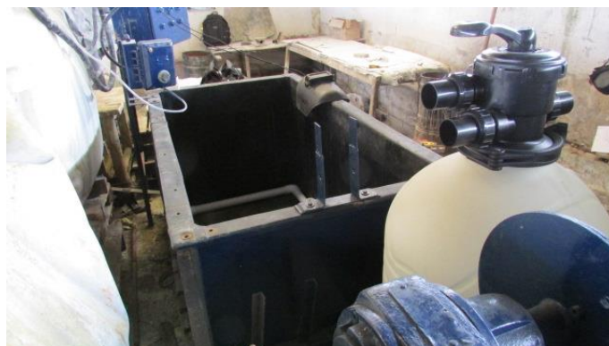
Figura 4. 23. Montaje del sistema de recirculación y agitación en la Cuba
