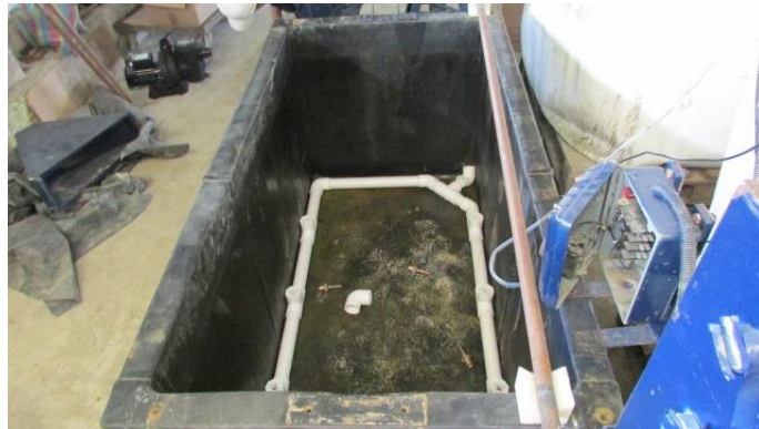
Figura 4. 12. Pegado de Tuberías
