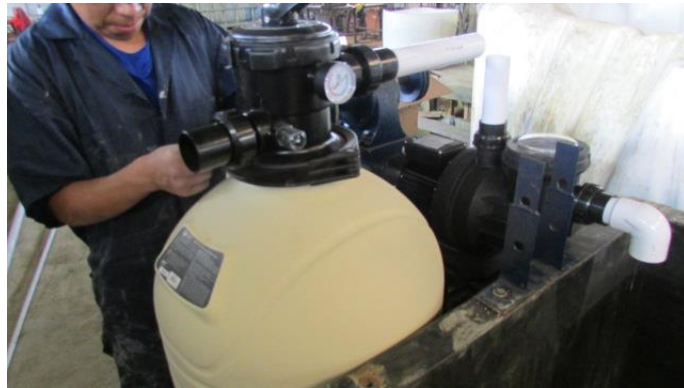
Figura 4. 24. Montaje del Filtro
