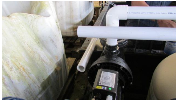
Figura 4. 25. Montaje Filtro Bomba
