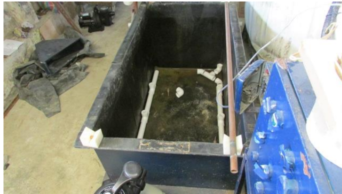
Figura 4. 11. Construcción interna del sistema de Tuberías
