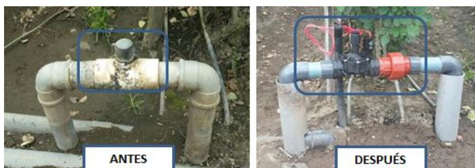
**Figura 5.5. Remplazo de válvulas de riego.**
