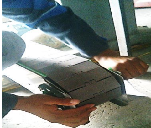
Figura 4. 12 Montaje de la cinta transportadora
