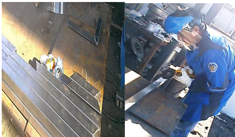
Figura 4. 7 Trazado y corte del tubo para la construcción
