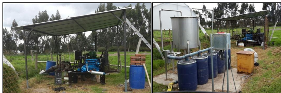
Figura 3. 17. Cuarto me maquinas terminada.
