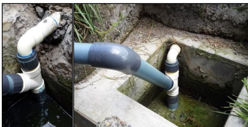
Figura 3. 3. Acople de la tubería.
