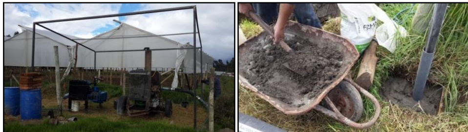
Figura 3. 16. Construcción de la estructura del cuarto de máquinas.
