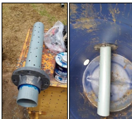
Figura 3. 5. Tubería perforada en la parte inferior.
